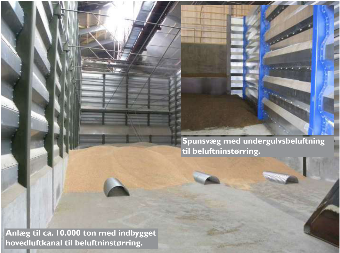
Spunsvæg - enkel montage med håndterbar dele.
